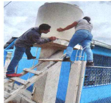
Foto 6: Instalación del Depósito de agua
