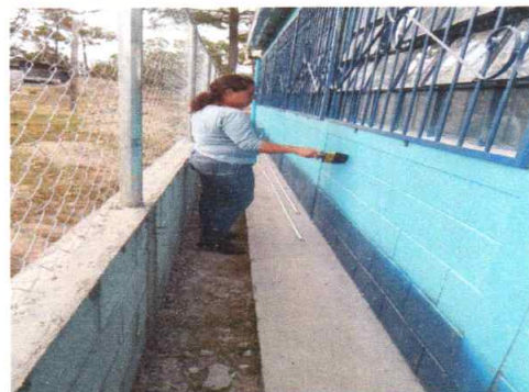
Foto 2: Aplicación de pintura en todo el centro educativo
