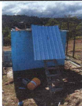
Foto1: Cambio de cubierta de lámina y estructura de soporte en baños
