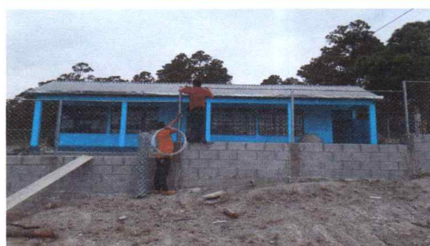
Foto 4: Realización del Muro perimetral
