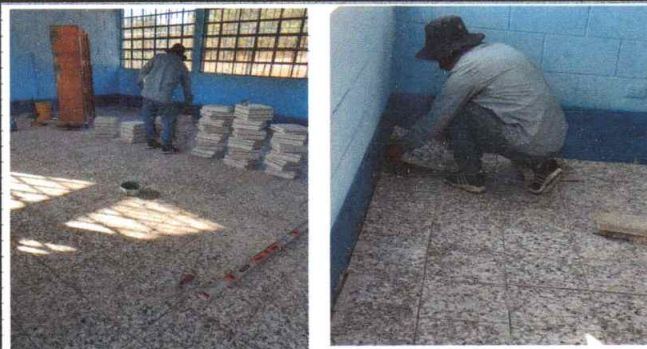
Foto 6: Colocación de piso de granito a las aulas
