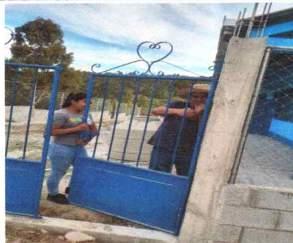
Foto 2: Instalacion del Portón de metal
