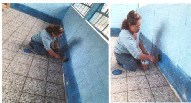
Foto 3: Aplicación de pintura en todo el centro educativo
