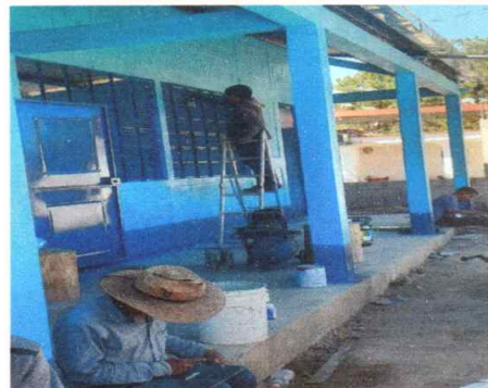
Foto 4: Mantenimiento a Estructura de ventanas y colocacion de vidrios quebrados
