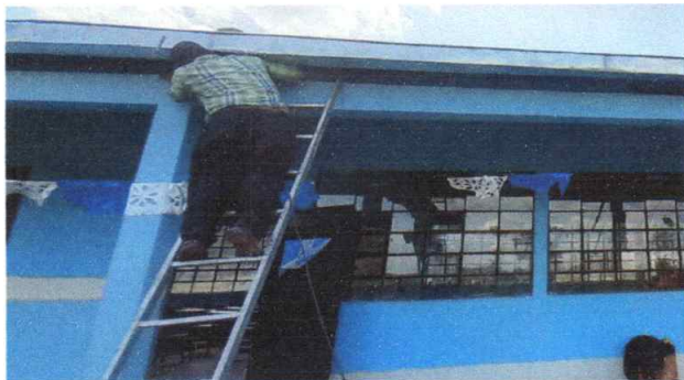
Foto1: Instalacion de los canales
