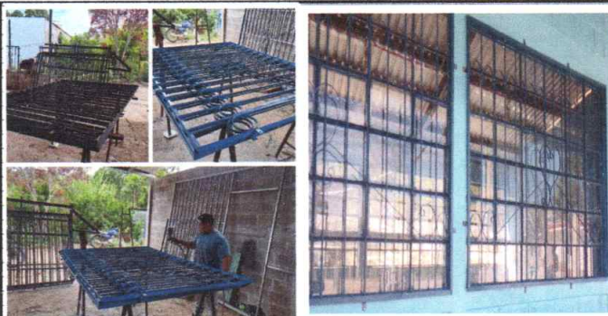
Foto 5: Elaboración y colocación de los balcones a ventanas
